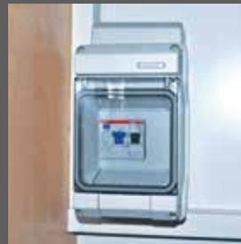
Verteilerkasten mit FI und
